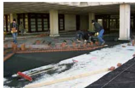
Igualmente, el relleno de juntas del pavimento seguirá los estándares. Se recomienda rellenar las juntas con mucho esmero para garantizar la adhesión lateral necesaria y considerar el mantenimiento regular necesario para conservar el buen estado del mismo.
