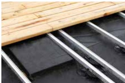
Otra variante es el uso bajo terrazas de madera. La pendiente deseada se puede realizar mediante los soportes elevadores.
