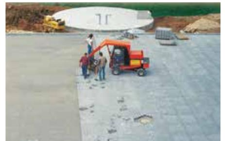
Con Elastodrain® es posible colocar la capa soporte y también las otras capas superiores de modo frontal, incluso con maquinaria pesada.
