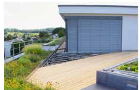
Esta terraza de madera sube constantemente desde el „punto forzado de salida de la puerta“ hasta el borde de la cubierta, ganando así altura para ubicar el sistema de la cubierta verde.
