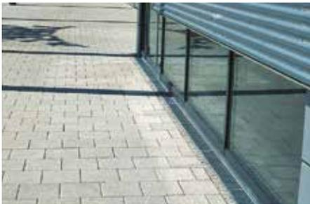
Con una superficie drenada con Stabilodrain® SD 30 no hay problema en recoger el exceso de agua de lluvia que se acumula en las fachadas y se recogen en canaletas.
