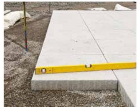
Después de extender el filtro TG sobre la capa de drenaje, sigue la colocación y nivelación de la capa de relleno para asegurar la estabilidad necesaria del pavimento.
