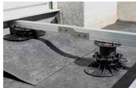
Los escalones, descansillos y otras obstrucciones son fáciles de construir combinando los soportes elevadores Elefeet® con el sistema de rieles de soporte Elefeet®.
