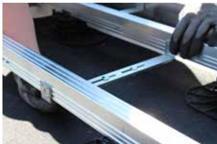
El espaciador variable se adapta a cualquier formato de pavimento deseado y asegura una subestructura estable con dimensiones constantes.
