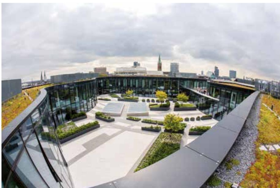
del edificio incluye un ajardinamiento extensivo de la cubierta con el elemento de drenaje Floraset® FS 50 y un ajardinamiento intensivo de las dos cubiertas transitables del patio interior con la banda de drenaje Fixodrive® FX 50. El elemento de drenaje Stabilodrain® SD 30,
