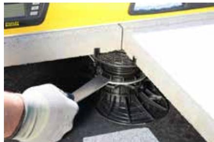
Cada soporte elevador Elefeet® puede adaptarse a la altura deseada usando la llave de ajuste disponible como accesorio, incluso posteriormente al tener que cambiar alguna losa.
