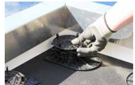
La nueva placa base Elefeet® permite colocar el soporte elevador hasta el borde de la cubierta e incluso directamente en las esquinas después de cortarla a lo largo de la línea marcada.
