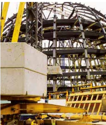
Durante la fase de construcción, muchas veces se utilizan las cubiertas planas para almacenar material o colocar maquinaria de construcción, como p. ej. en la cubierta del Parlamento Reichstag en Berlín.
