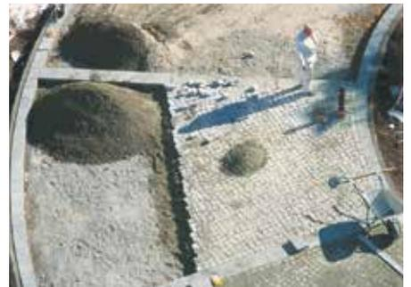
Con Floradrain® FD 60 y sobre la capa soporte de gravilla (ver páginas anteriores) o sobre la capa soporte de hormigón, es posible instalar capas de soporte
