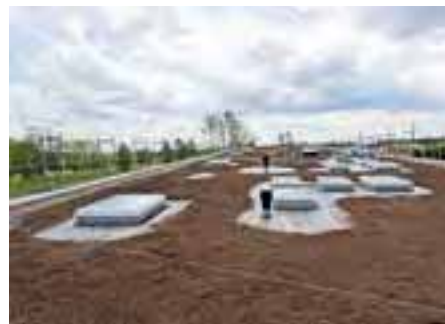
El sustrato Zincoterra "Floral" instalado sobre la cubierta.
