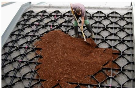
Los elementos Georaster® se deben cubrir con aprox. 15 - 20 mm de sustrato más que la altura del Georaster para protegerlos de la radiación solar.
