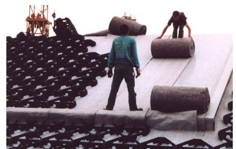
Colocación de la Manta hidroabsorbente WSM 150
