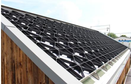
Desagüe exterior con Perfiles de aleros TRP 140 y Soportes antiempuje LF 600.
