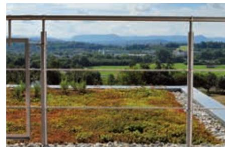
Sistema de base para barandillas ZinCo es atractivo y funcional, y además se instala sin necesidad de perforar la impermeabilización.
