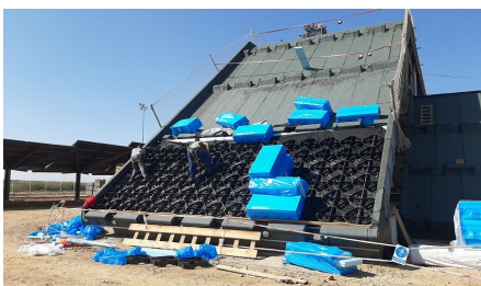
En las superficies inclinadas, se crearon y sellaron fuertes barreras de retención para distribuir las fuerzas de empuje.
