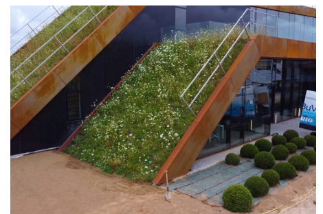
Las cubiertas inclinadas poco después de la instalación de las mantas precultivadas de vegetación de ZinCo. El riego se instaló bajo la vegetación.
