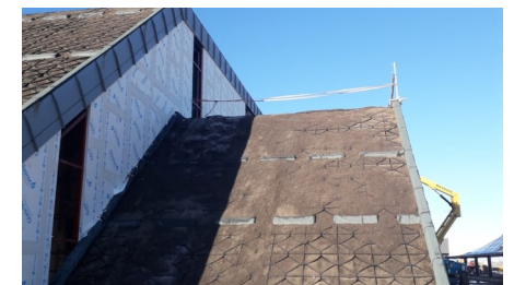
Los elementos Georaster evitan la erosión del sustrato aplicado.
