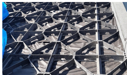
Tras instalar la lámina de separación TGV 21, se colocaron los elementos Georaster.
