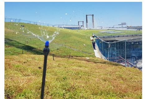
Imagen tras la plantación de la manta precultivada de vegetación. En cubiertas inclinadas, y aún más en climas secos, la instalación de un sistema de riego es imprescindible.
