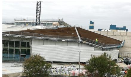
Después de instalar la manta BSM 64 y el elemento de drenaje FS 75, el sustrato Zincoterra Floral fue aplicado en varias zonas.
