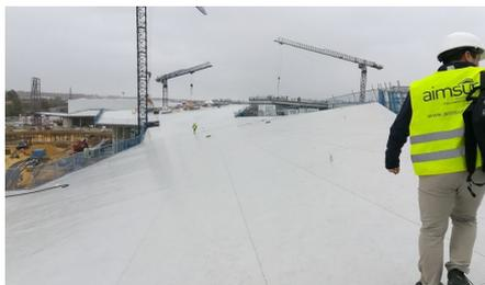
Para instalar el sistema de cubierta verde se preparó la cubierta con una impermeabilización antirraíces en toda la superficie .
