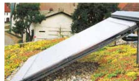
La generación de energía solar también es posible en las cubiertas verdes inclinadas. Habrá que estudiar en cada caso individual, cómo se pueden instalar los equipos sin fijarlos mecánicamente a la estructura, como por ejemplo, con la Base Solar de ZinCo.
