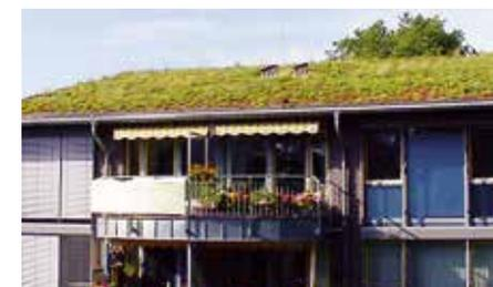
Para dimensionar los bordes perimetrales o las barreras de retención adicionales, no solo es decisivo el peso de la estructura de la cubierta verde saturada de agua, sino también las cargas de nieve estimadas para la localidad del proyecto.
