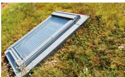
En el caso de que haya elementos emergentes en la cubierta, la capa impermeable deberá sobrepasar 10 cm, como mínimo, por encima del borde superior de la capa de sustrato. El sistema constructivo de la cubierta verde puede bordearse lateralmente con el perfil de aleros TRP 140 de acero inoxidable en combinación con soportes antiempuje (como nuestros soportes antiempuje TSH o LF).
