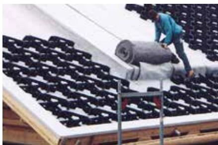
Después de haber colocado la manta hidroabsorbente WSM 150 por toda la superficie, se empiezan a instalar y a unir los elementos Georaster® desde el punto más bajo de la cubierta.
