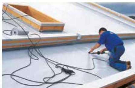
Se sella la superficie de la cubierta con una lámina impermeabilizante, certificada lámina antirraíz conforme al procedimiento establecido por la FLL.
