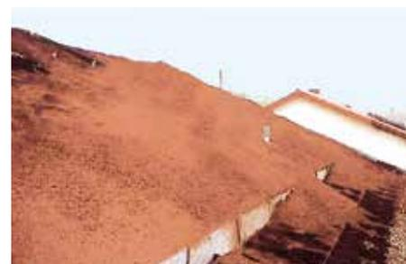
Se rellenan con sustrato técnico para cubiertas verdes como nuestro Zinco terra „Aromáticas“. Se suministra en big bag o a granel y se distribuye uniformemente, hasta que los elementos Georaster® estén cubiertos de unos 15-20 mm de sustrato.
