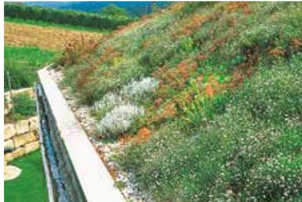
Varios meses tras la instalación, la capa de vegetación finalmente ha cubierto más del 80 % de la superficie. En la imagen el drenaje se realiza mediante un canalón exterior que conduce el agua sobrante por 3 gárgolas.
