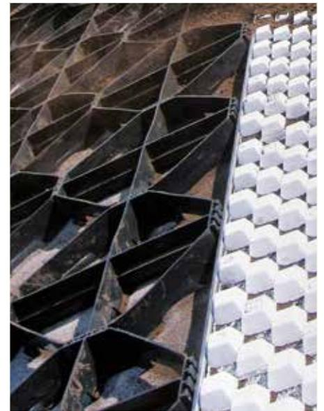
sistema "Cubierta inclinada hasta 20°" en el área superior con un pendiente menor fue posible gracias a la barrera de retención construida con los perfiles de alero TRP. El elemento de drenaje Floraset® FS 75 retiene y estabiliza perfectamente el sustrato.
