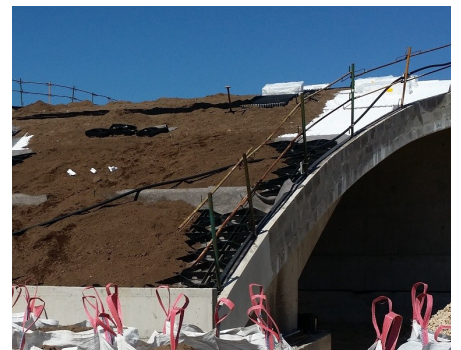
Los elementos FS 75 y los elementos Georaster se instalaron para estabilizar el sustrato.
