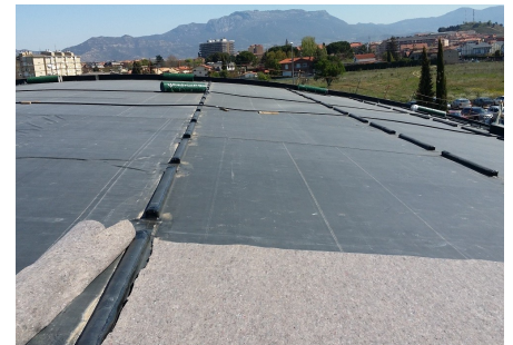
Se hormigonaron y sellaron numerosas barreras de retención para la absorción de las fuerzas de empuje. Posteriormente, se colocó la manta protectora e hidratante BSM 64.
