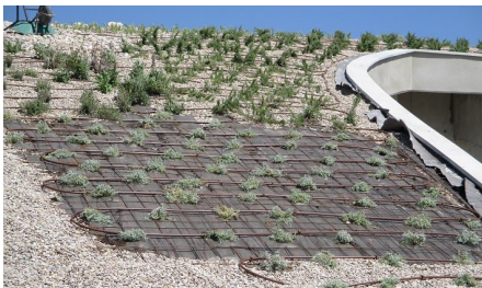
La imagen muestra la instalación del riego por goteo y de la plantación en 2017
