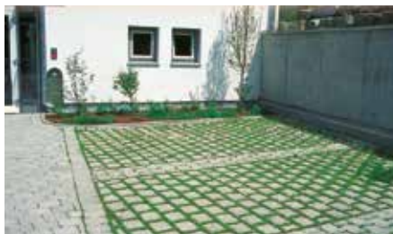
Juntas verdes de una superficie adoquinada
