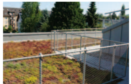
Las soluciones individuales de barandillas también se pueden montar en la base de barandilla: la unión se realiza en la contrabrida. Por lo demás, no hay límites para la creatividad.
