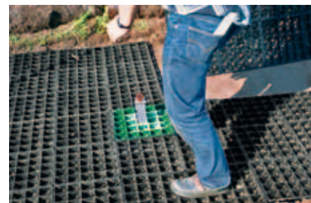
Finalmente todos los elementos modulares conforman una placa distribuidora de la tracción de aprox. 5,3 m².
