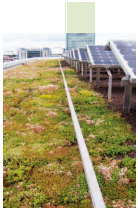
Aplicaciones más habituales del sistema de anclaje lineal Fallnet®: áreas perimetrales, donde el trabajo realiza de manera reiterada. Una vez anclado al anillo corredizo todas las actividades se realizan con total seguridad.
