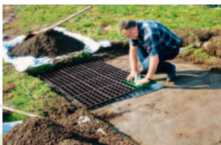
El sistema Fallnet® SR se puede montar en cubiertas ajardinadas ya existentes. En esta fotografía se puede apreciar cómo se fija el punto de anclaje en el elemento modular.
