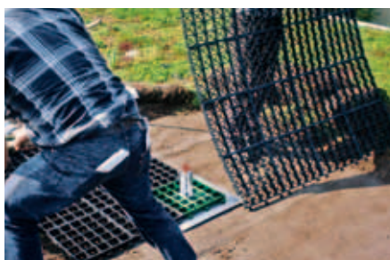
Una vez instalada la placa base de manera céntrica, se unen los demás elementos con el elemento modular inicial..
