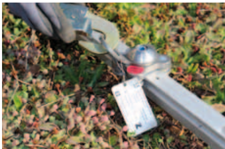
Con el anclaje lineal montado horizontalmente, se puede aprovechar todo el radio de movimiento alrededor del anillo corredizo. Es por ello que el sistema es muy eficaz para ser utilizado en superficies estrechas de cubierta.
