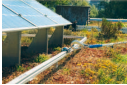
Dispositivo de anclaje en funcionamiento. El punto de anclaje corredizo para equipos de protección anticaída garantiza la máxima facilidad de manejo.
