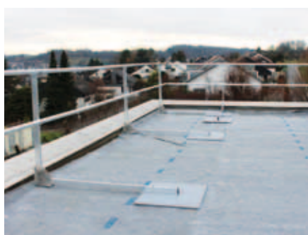
Aquí se muestran los módulos de postes antes de aplicar el sistema de cubierta verde.
