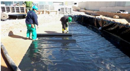
En las áreas de siembra, delimitadas por muros de piedra, se instaló, en primer lugar, lámina antirraíces WSF 40.
