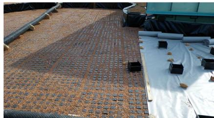
El elemento de drenaje y retención de agua Floradrain® FD 60 fue relleno con Zincolit® y cubierto con el filtro sistema SF.
