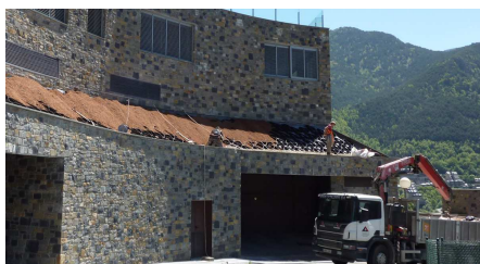
La mayor dificultad para los instaladores fue distribuir las fuerzas de empuje en esta cubierta con fuerte pendiente.
