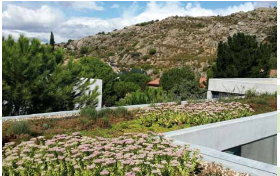
Cubierta verde en la provincia de Madrid
