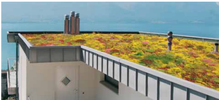
Cubiertas verdes extensivas
