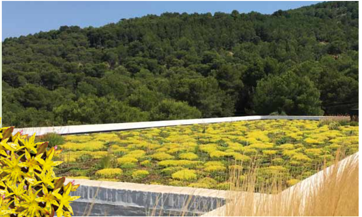
Cubierta extensiva en Andalucía
