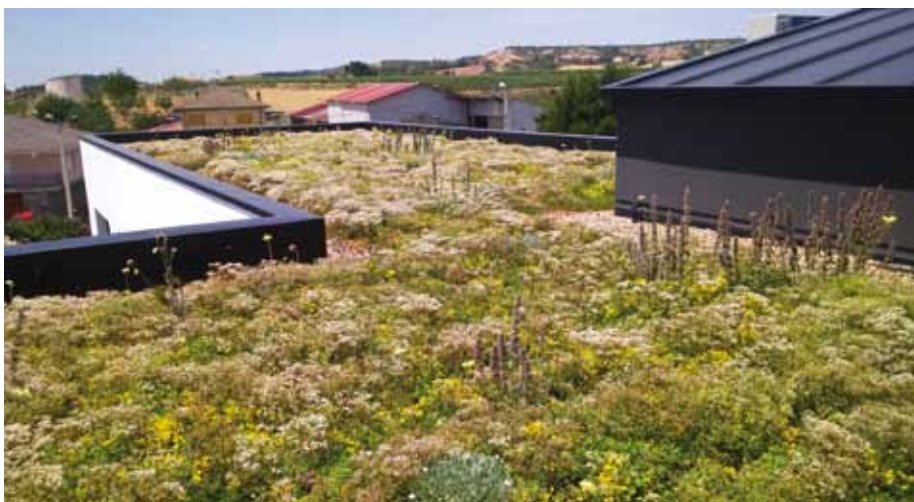
Cubierta extensiva en Burgos
