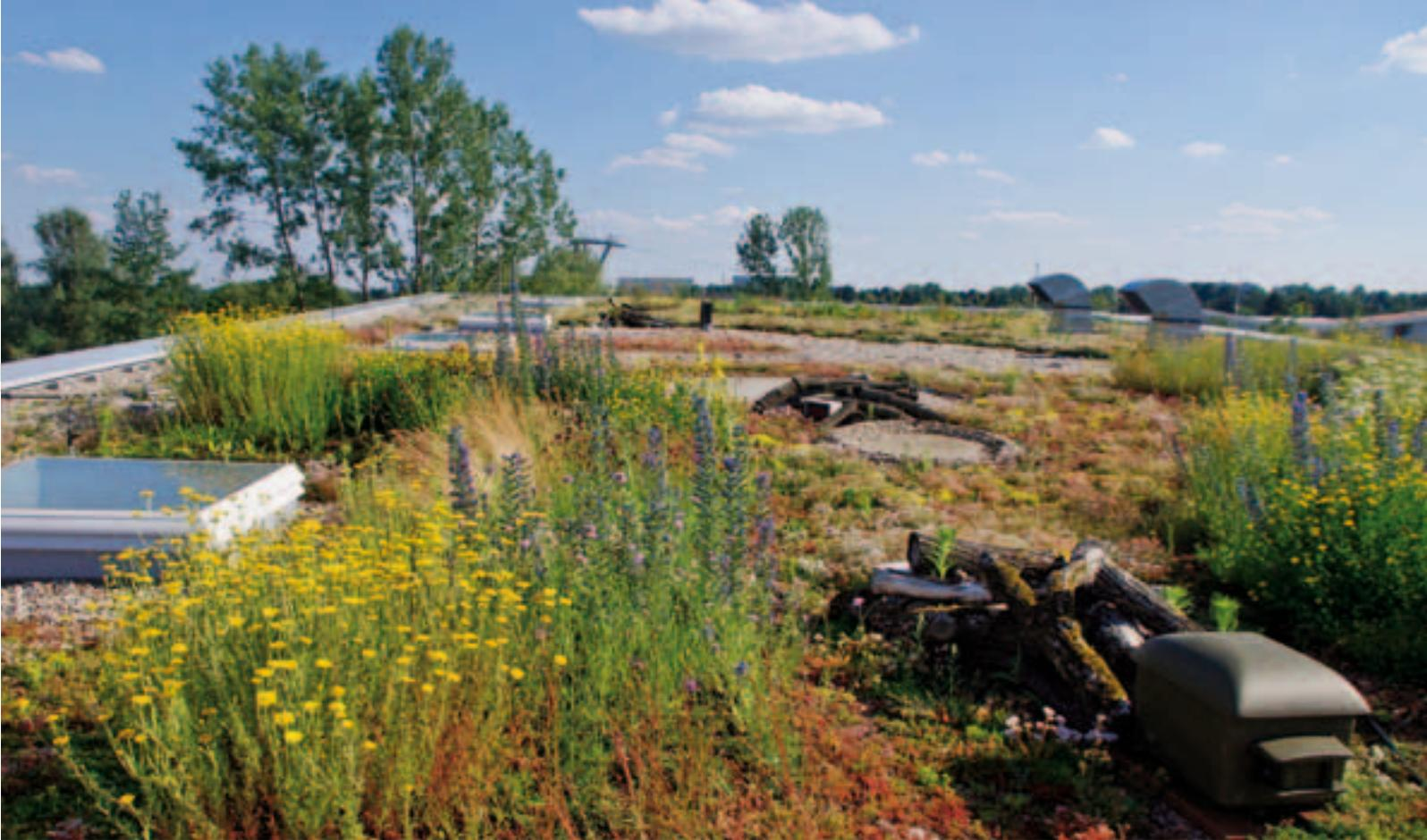
El sistema de cubierta verde "Tapizante floral" con el elemento de drenaje Floradrain® FD 25-E , puede ser la capa de asentamiento sobre el que se instale la cubierta biodiversa.
