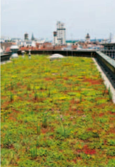
En climas secos y cálidos, como el clima mediterráneo, todas las cubiertas verdes precisan de un sistema de riego incorporado, incluso las cubiertas extensivas con Sedums.
