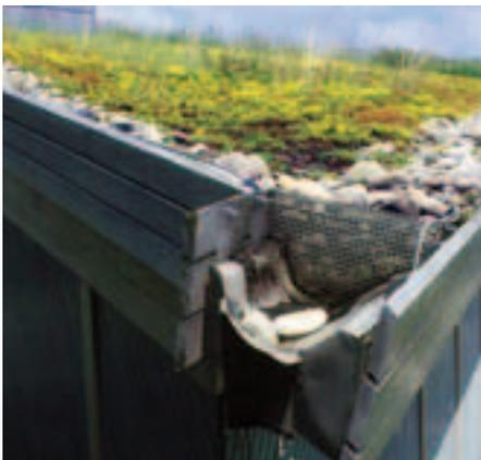
Reducción de la escorrentía del agua en una cubierta verde extensiva.
