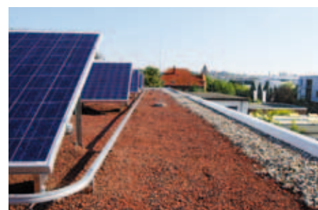
Instalación sin necesidad de perforar la impermeabilización, gracias al lastrado proporcionado por Zincolit®, el sustrato ZinCoterra o un material alternativo a granel.
