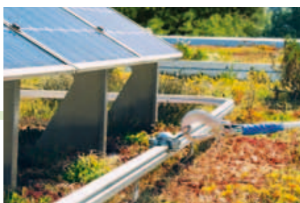
El anclaje corredizo del equipo de protección personal es de fácil manejo, y permite al usuario una sujeción segura y libertad de movimientos.
