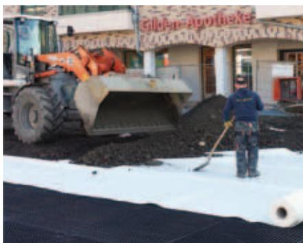
Incluso en la fase de construcción, una capa protectora es vital para evitar dañar la impermeabilización de la cubierta.
