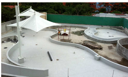
La zona de la piscina se puede ver claramente después de la finalización de la estructura.
