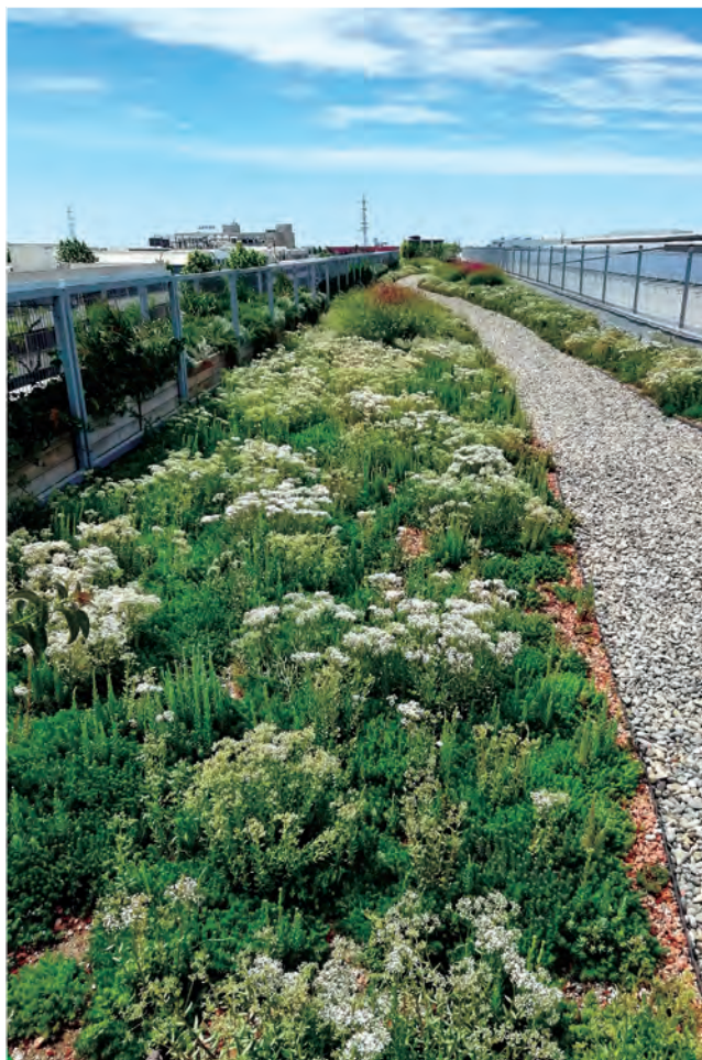
Un aspecto fundamental es la impermeabilización
