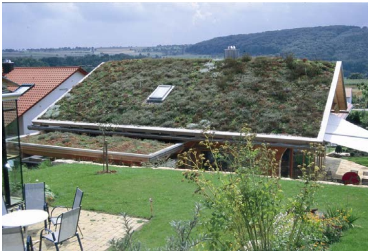
Imagen nº 1: Cubierta de la casa de madera
