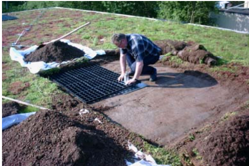
Nombre del archivo: Colocación de Fallnet® SR 1.jpg
