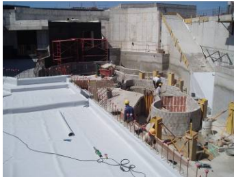
Colocación de las bandas Antirraíz WSB 80-PO
